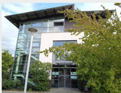
Eingang zum Pflegestützpunkt
